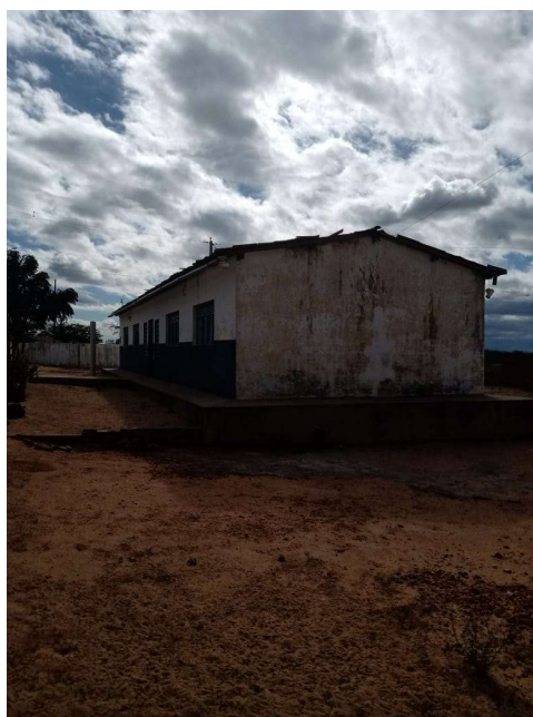
FOTO 03: FACHADA LESTE EXISTENTE DA ESCOLA GEORGINA JOSEFA DE SOUSA.
