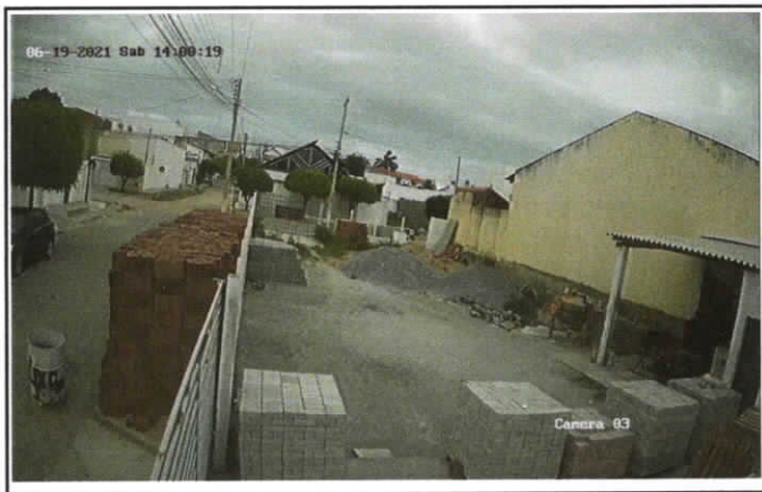
Deposito de Materiais e Premoldado
