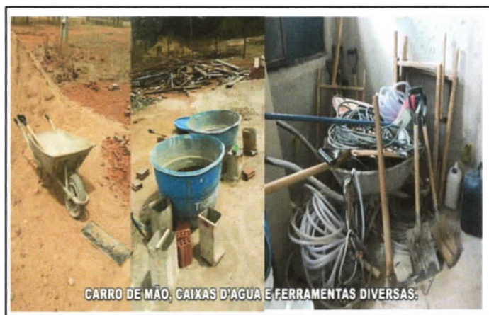
Equipamentos, Materiais e Ferramentas
