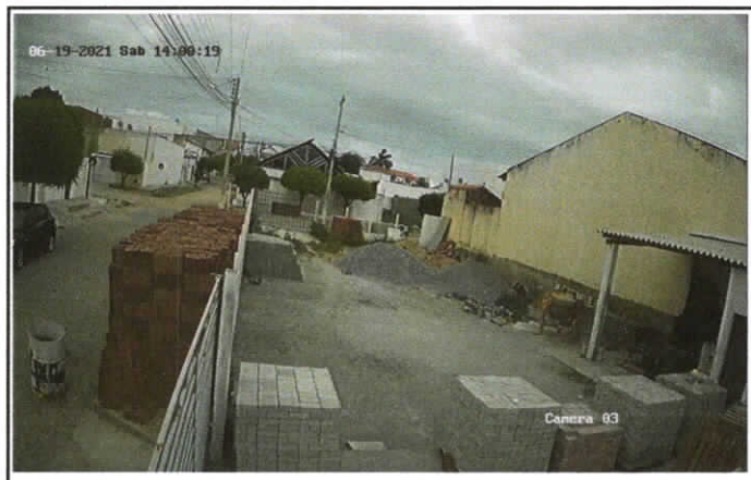
Deposito de Materiais e Premoldado
