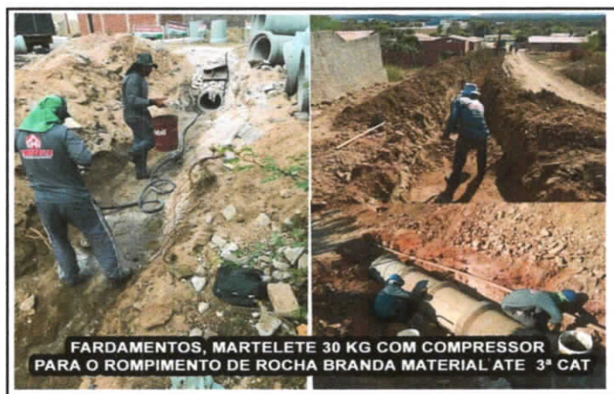
Maquinas, Fardamentos e Epis
