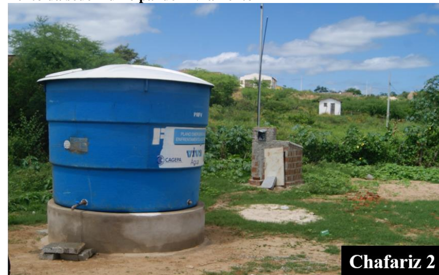
Figura 3.69 – Chafarizes utilizados no abastecimento da sede municipal de Livramento
