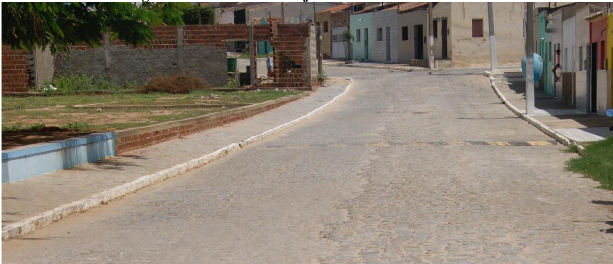
Figura 3.125 – Rua com sarjeta na cidade de Livramento
