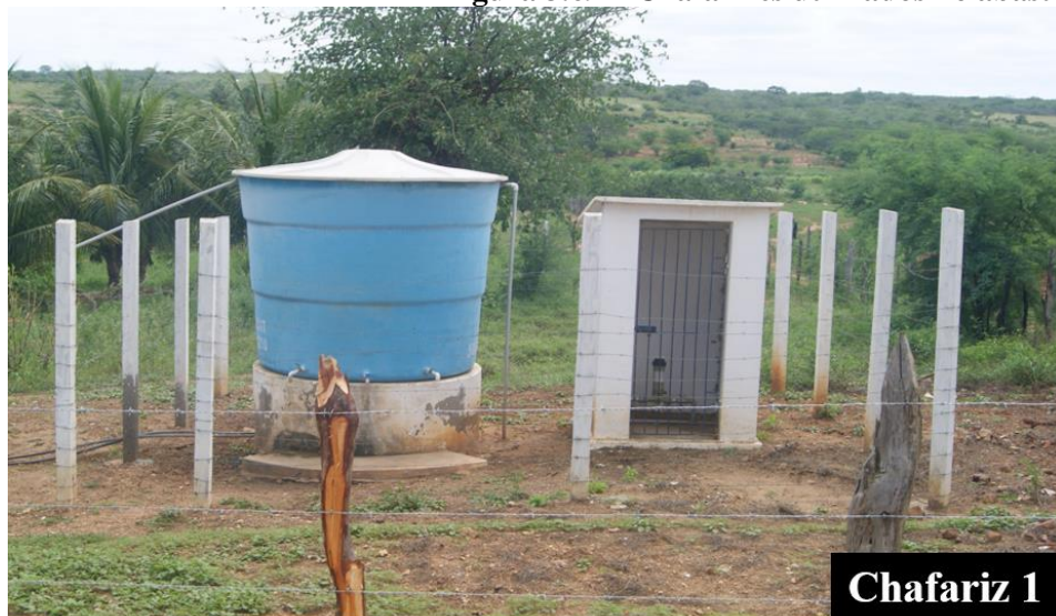
Figura 3.69 – Chafarizes utilizados no abastecimento da sede municipal de Livramento
