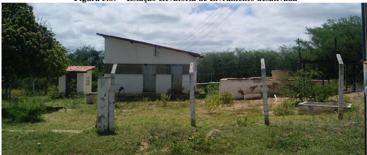
Figura 3.89 – Estação elevatória de Livramento desativada
