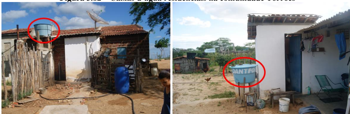
Figura 3.82 – Caixas d'água residenciais na comunidade Torrões
