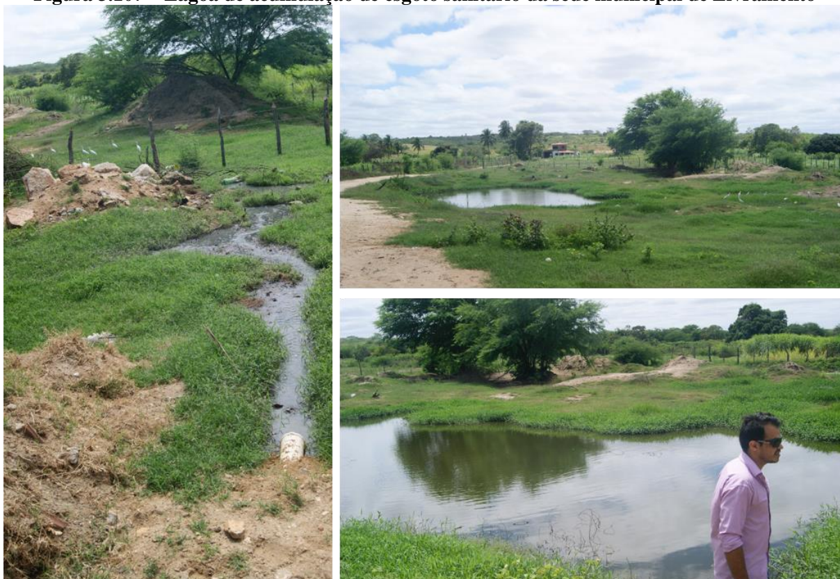
Figura 3.107 – Lagoa de acumulação de esgoto sanitário da sede municipal de Livramento
