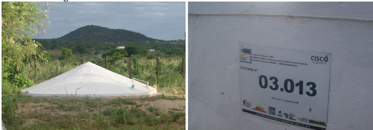
Figura 3.94 – Cisternas individuais utilizados no SAA de Livramento
