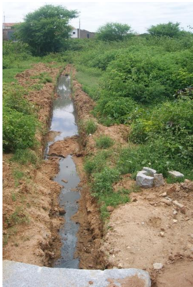
Figura 3.103 – Canal aberto da rua Teodomira Ferreira Portela
