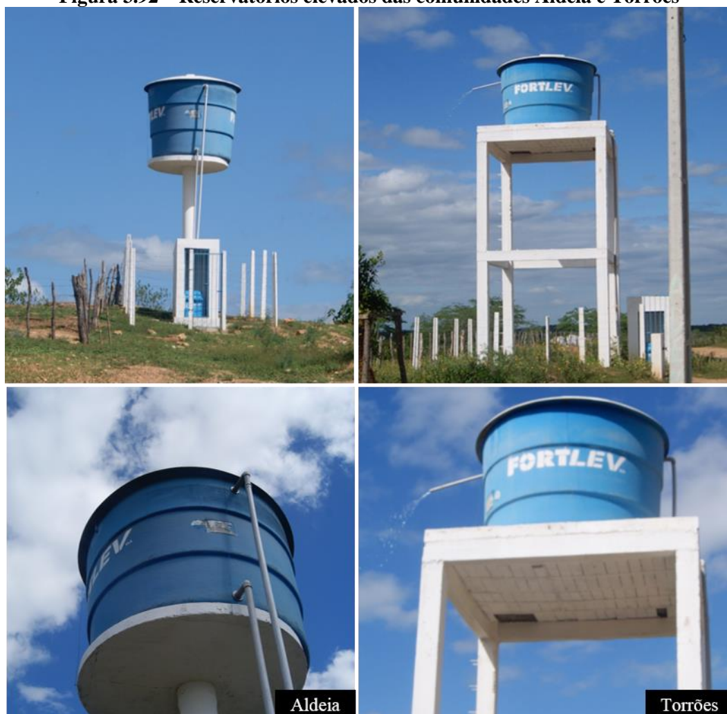
Figura 3.92 – Reservatórios elevados das comunidades Aldeia e Torrões
