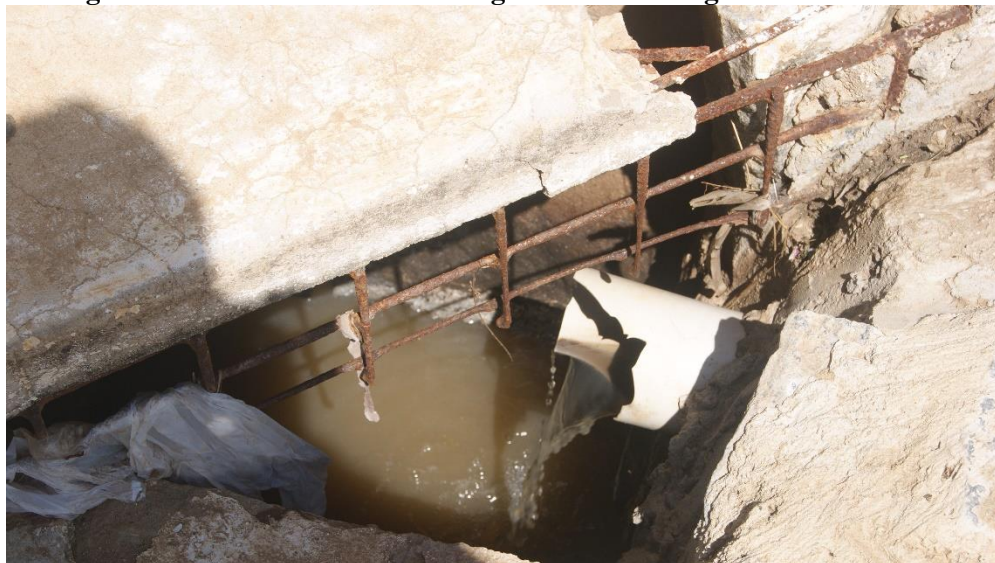
Figura 3.133 – Boca de lobo interligada a rede de esgotamento sanitário
