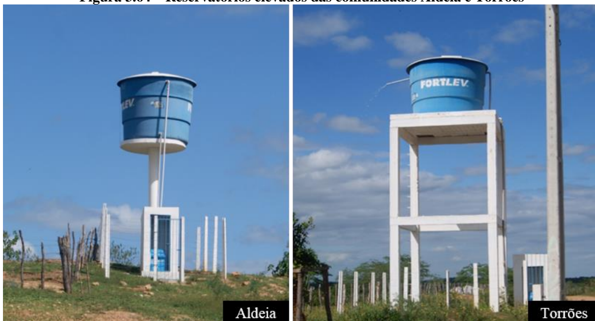
Figura 3.64 – Reservatórios elevados das comunidades Aldeia e Torrões
