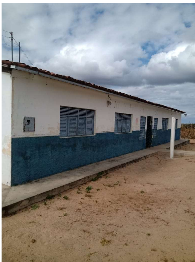
FOTO 01: FACHADA SUL EXISTENTE DA ESCOLA GEORGINA JOSEFA DE SOUSA.
