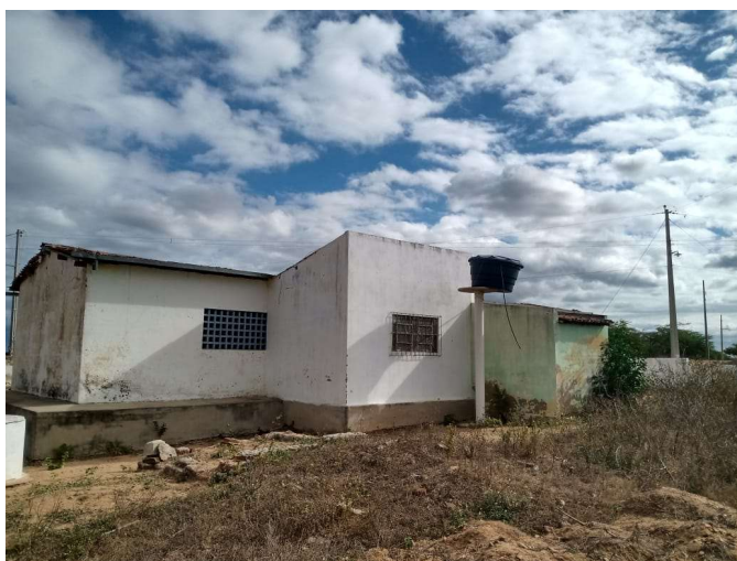
FOTO 02: FACHADA NORTE EXISTENTE DA ESCOLA GEORGINA JOSEFA DE SOUSA.
