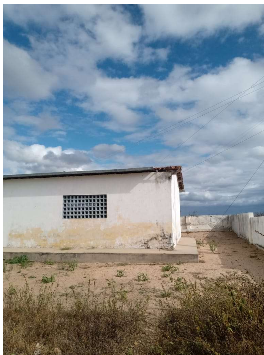
FOTO 04: FACHADA OESTE EXISTENTE DA ESCOLA GEORGINA JOSEFA DE SOUSA.
